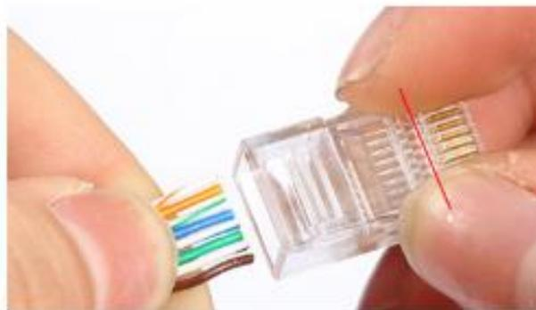
4 按照图示将剪平后的线缆插入水晶头，从前端或侧面检查
