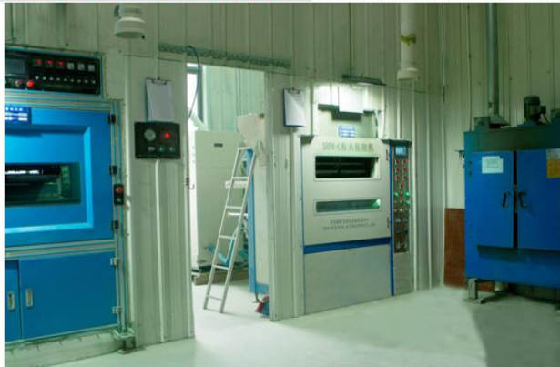
工厂车间图：环氧封装站
