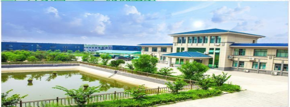
工厂外景图：工厂侧视全景
