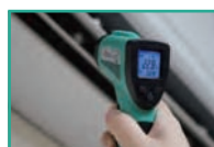
冷气空调出风口 温度测试
