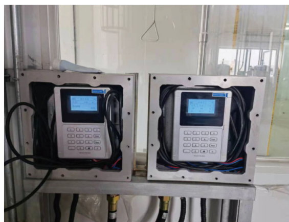
防爆式超声波流量计安装案例
