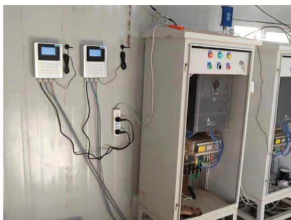
企业用4G无线远传超声波流量计实时监测
