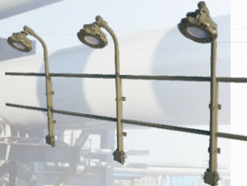
护栏式实际安装案例
